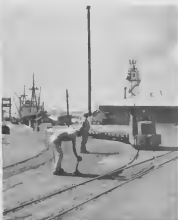
TRINAN tabata worde switchá for di linea mayor pa finger piers, otro spur. Costo di mantene riel, switch tabata factor den fin.
